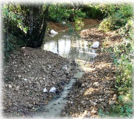
Recharge granulométrique
