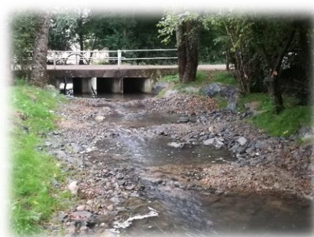
Aménagement d'un seuil de pont
