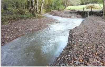
Restauration de rivière - CCVG
